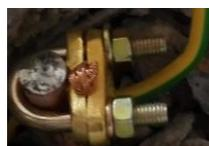
Elemento de conexión del cable de cobre de protección a tierras con el electrodo de puesta a tierra (pica).
